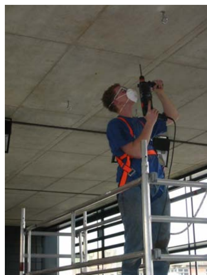
Abb. 3.4.: Bohren der Dübellöcher
