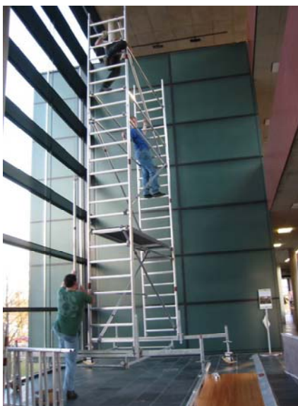
Abb. 3.3.: Aufbau des Montage-Gerüsts
